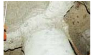
鉄骨耐火被覆
